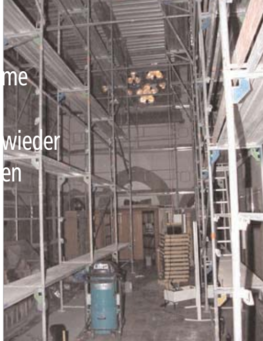
Die komplett eingerüstete Kirche während den Handwerkerarbeiten.
