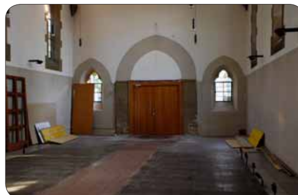
Eingangsbereich nach der Demontage des Windfangs
